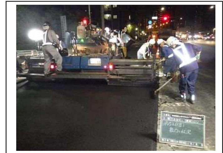
水溜が確認された交差点部の表層工（アスコン舗設状況）
