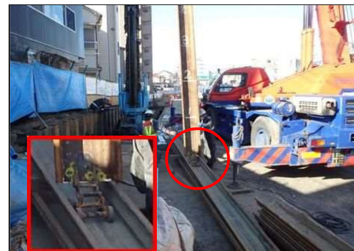
パイルローラーを使用した騒音対策
