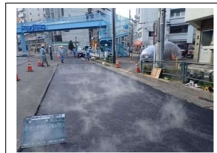
終点部付近の三つ又交差点の施工
