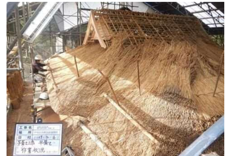
屋根：茅葺き状況
