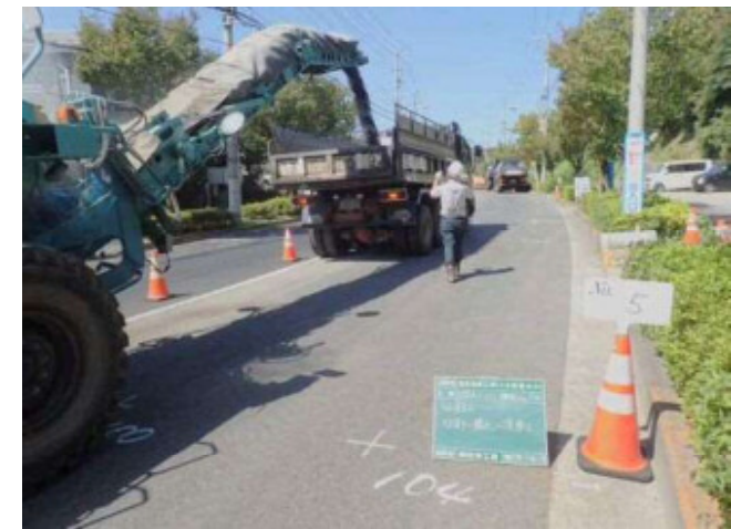
切削打換え工（廃材積込み状況）
