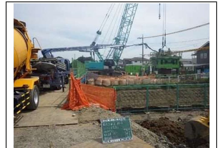
場所打杭コンクリート打設工（A1-1）
