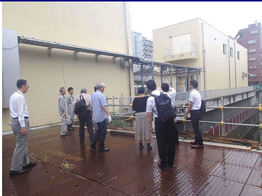
説明状況(取水堰)
