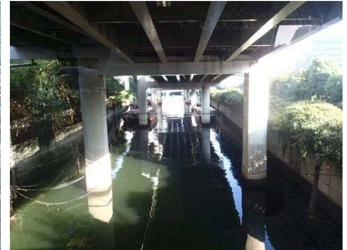
古川(浜崎橋上流付近)
