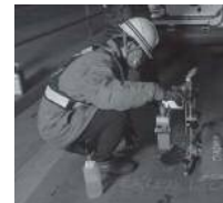
すべり測定状況(多摩部)
