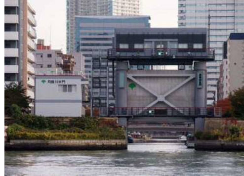
月島川水門(中央区月島三丁目地内)
