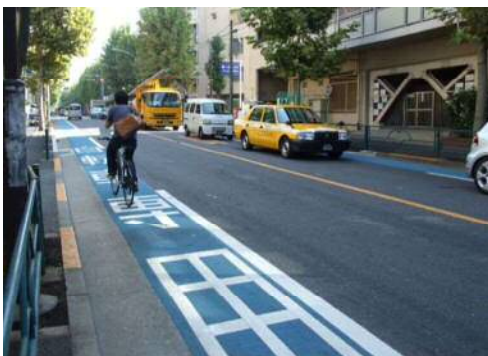
自転車走行空間整備事業(渋谷区幡ヶ谷 旧玉川水道道路) 自転車レーンや広い歩道を活用した自転車歩行者道など、地域の道路事情に応じた整備手法により、安全で快適な自転車走行空間の整備を進めている。
