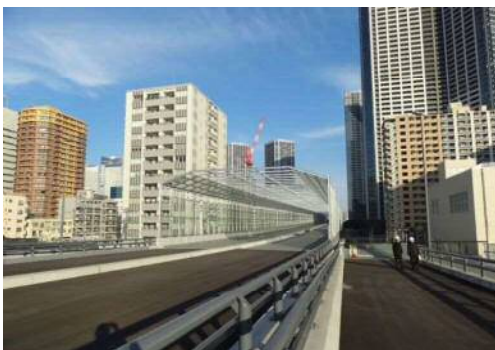
環状第2号線 現在、江東区豊洲から港区虎ノ門までの約4.8kmの区間で事業中である。2022年度の本線開通を目指し整備を進めている。
