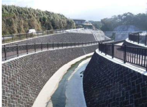
砂防事業(流路工)(大金沢 大島)
