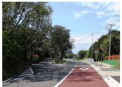
一般都道大島循環線(大島町) 泉津地区の約500m区間について平成30年1月に交通開放した。バイパスルートで道路整備を進めることで、集落や観光資源を保全しつつ、歩行者の安全や交通の円滑化を図っている。
