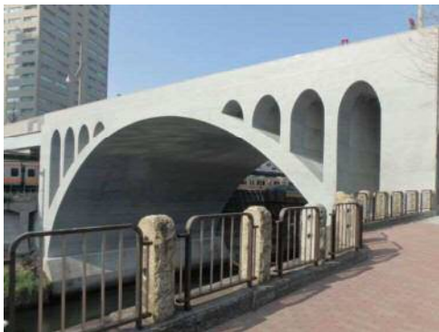
橋梁の長寿命化事業 (聖橋:千代田区神田駿河台四丁目～文京区湯島一丁目) 神田川に架かる聖橋は、耐震性や耐久性などの向上を図る長寿命化工事を実施している。
