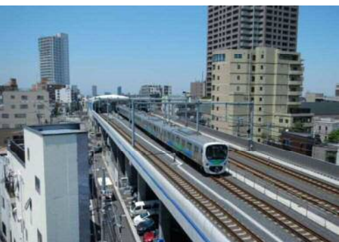
西武鉄道池袋線(練馬高野台駅～大泉学園駅間)連続立体交差事業 平成29年3月に事業が完了した。踏切による交通渋滞及び事故が解消されただけでなく、高架下空間の有効活用や事業を契機とした駅前再開発等、沿線まちづくりが進展している。
