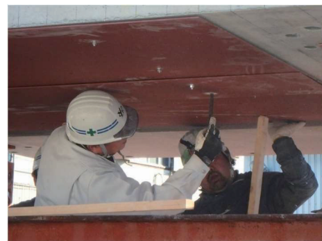
(b) 鋼板取付け
