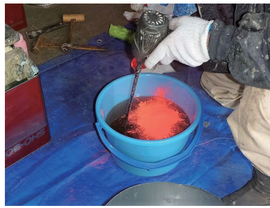
(b) 再注入樹脂(蛍光顔料混入) 写真-4 接着材再注入施工概要
