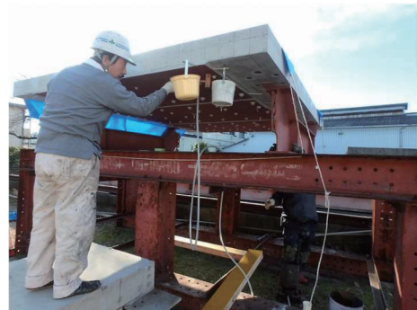
(c) 接着材の注入(空気抜き)
