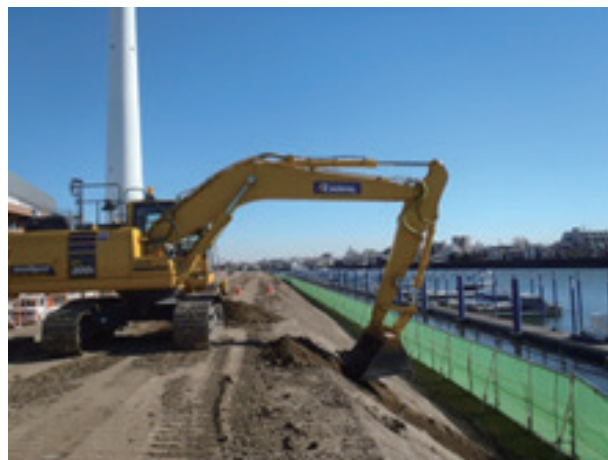
写真-1 Machine Control バックフォー
