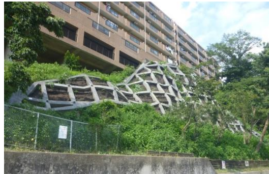
急傾斜地崩壊防止施設
