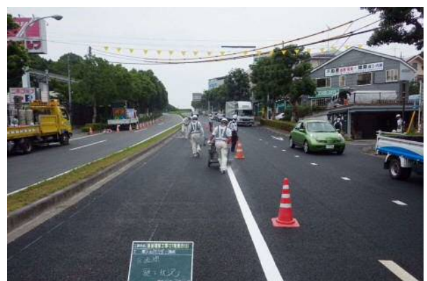
④区画線施工
