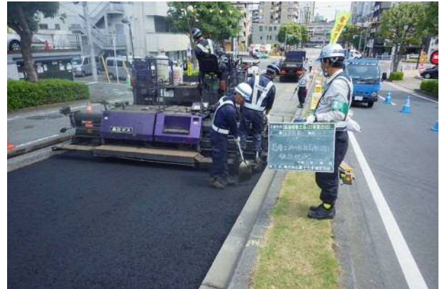
②アスファルト敷均し
