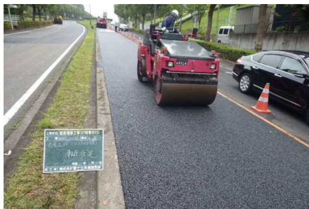
③アスファルト舗装転圧
