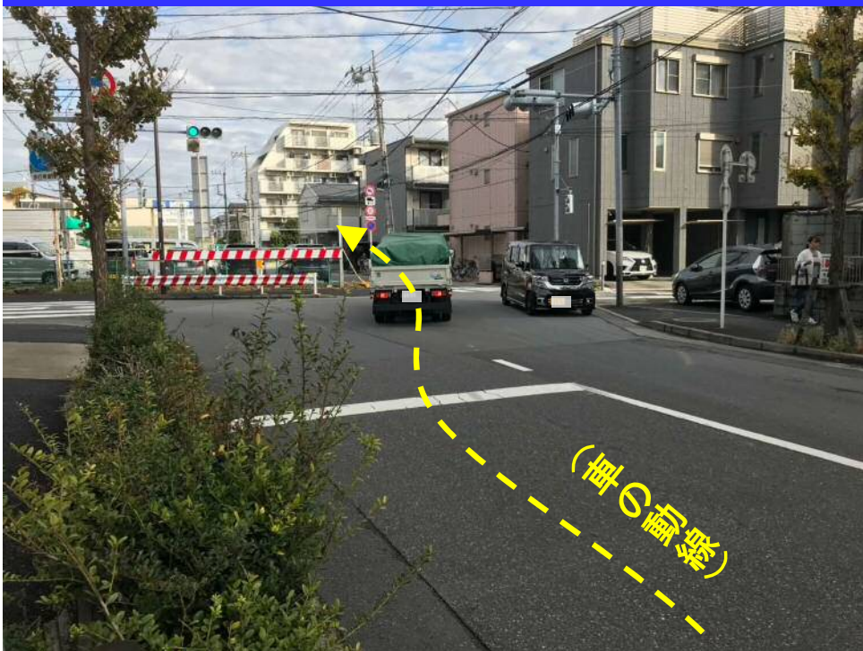
整備予定区間の起点側の状況
