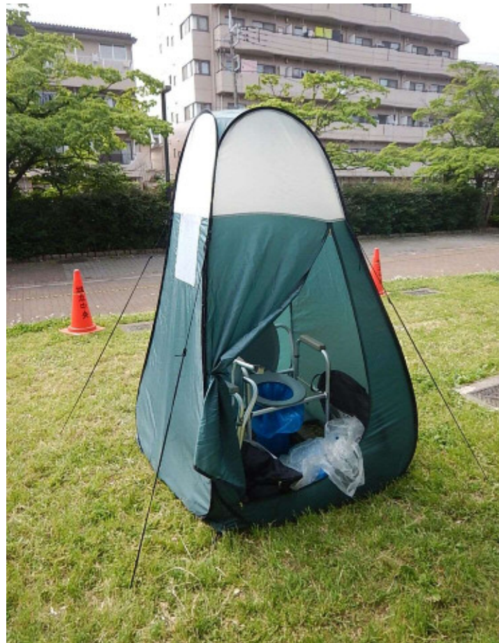
▲マンホール型トイレの組立の様子(訓練時の写真)
