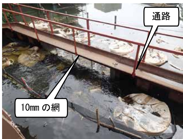
写真 1. 仮締切設置工事
