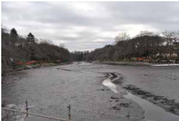
池底の水が抜けた状況 (平成 26 年 2 月 23 日)
