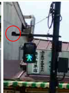
押ボタン式音響式信号機への変更。
