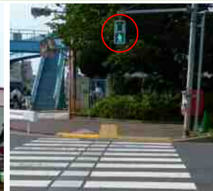
エスコートゾーン及び経過時間表示の設置
