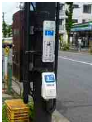
押ボタン式音響式信号機への変更。
