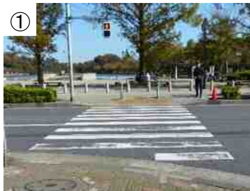
① 信号機はバリアフリー対応となっておらず、エスコートゾーンも設置されていない。
