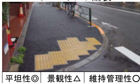
《アスファルト舗装》
