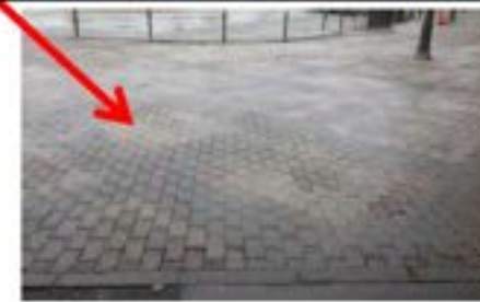
【特定事業③】インターロッキング舗装のがたつき解消
