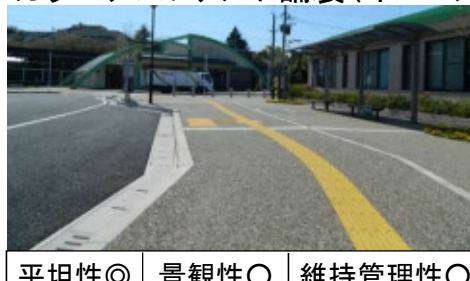
《カラーアスファルト舗装(イメージ)》
