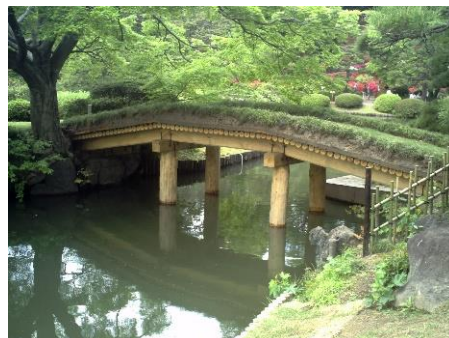
図 3-15 仙禽橋（整備後）（平成 20 年 4 月）
