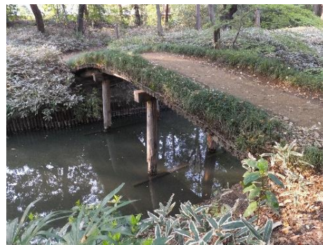
図 3-20 山陰橋（整備前）（平成 26 年 4 月）
