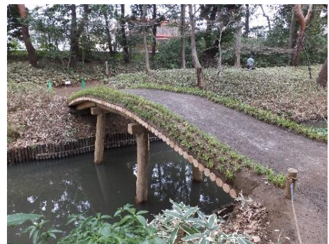
図 3-21 山陰橋（整備後）（平成 27 年 3 月）
