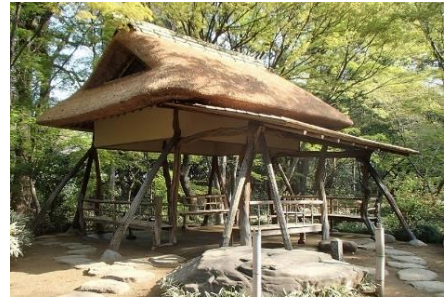
図 3-17 つつじ茶屋（整備後）（平成 26 年）
