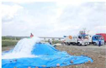
TEC-FORCE部隊の排水ポンプ車による緊急排水活動
