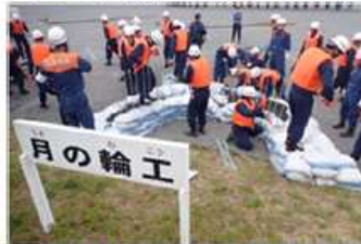
水防団による訓練 （月の輪工）
