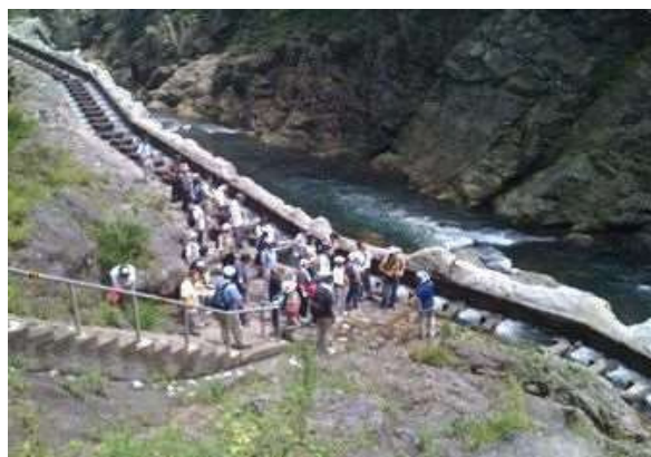
白丸ダム魚道
