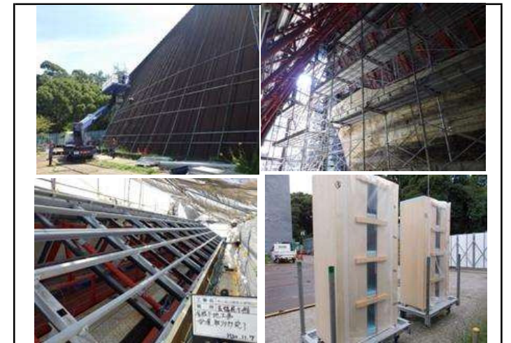
左上：外部足場 左下：屋根架替状況
