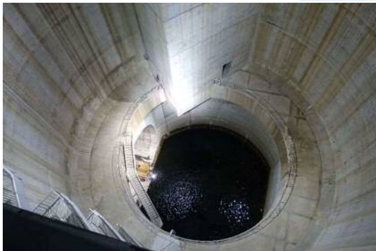
立坑内(施工前)
