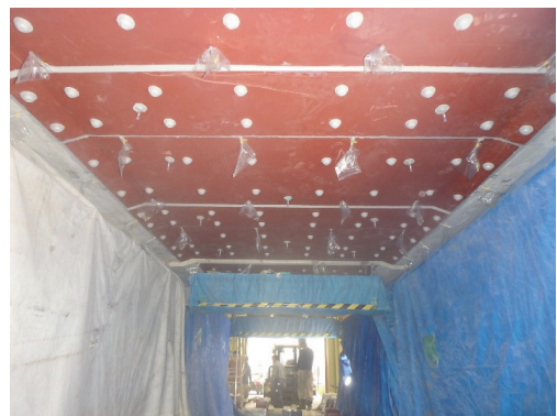
(b) 鋼板取付け接着材圧入 写真-2 鋼板接着施工状況
