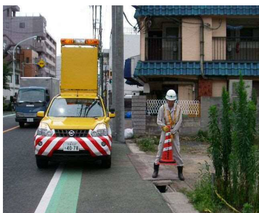
巡回点検 直営班の作業状況
