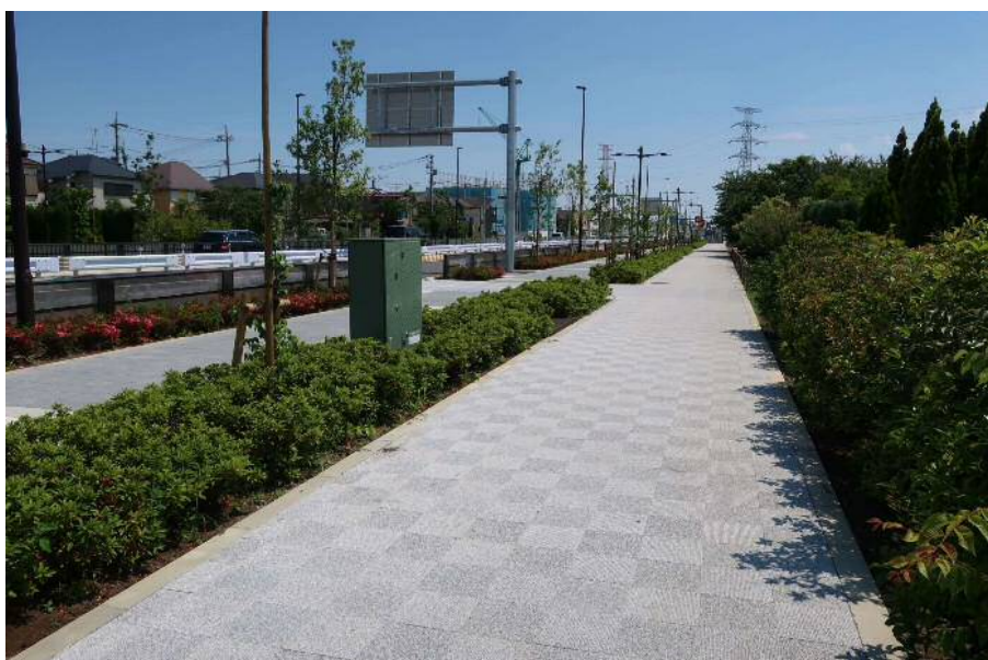
環境施設帯整備後
