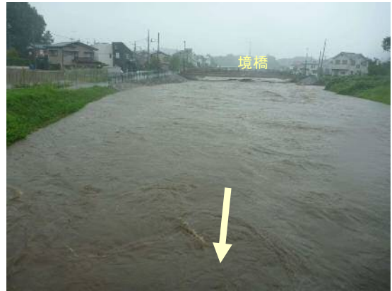
柳瀬川・境橋下流（平成28年8月22日増水時）
