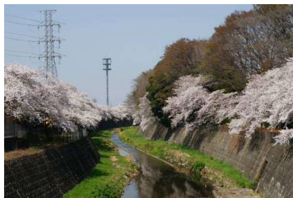
立川橋上流付近(立川市)
