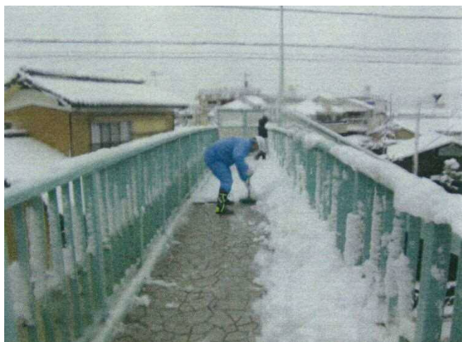
横断歩道橋の除雪作業
