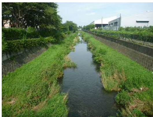
降馬橋下流付近(東久留米市)
