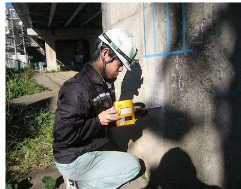
橋梁の点検状況
