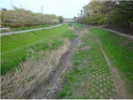
野川水涸れ状況（箭真舳橋より下流の状況）
