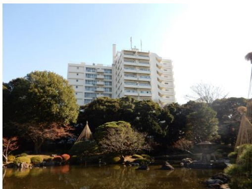
図 2-145 C : 南東側に隣接するマンション 平成 30 (2018) 年 12 月 21 日
