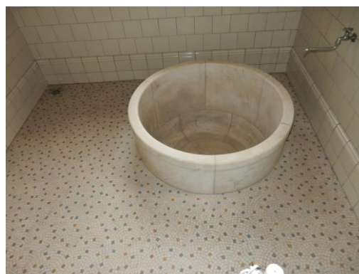
図 2-139 ⑭浴室 平成 31（2019）年 2 月 8 日
