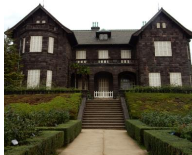
図 2-123 外観（南側） 平成 30（2018）年 12 月 10 日
