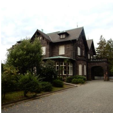
図 2-88 A：正門方向から洋館の景観 平成 30（2018）年 12 月 10 日
