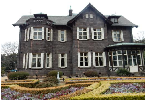
図 2-122 外観（東側） 平成 30（2018）年 12 月 10 日
