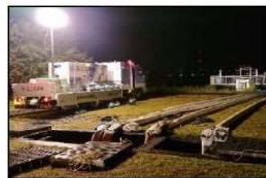
自治体委嘱による排水ポンプ車の派遣状況
