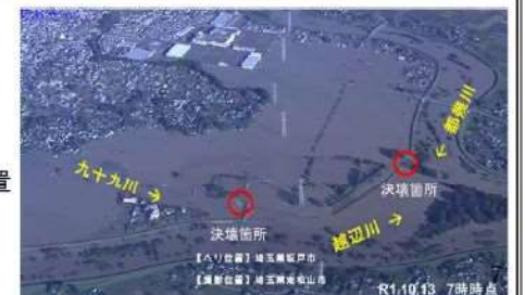
入間川流域における浸水被害状況
