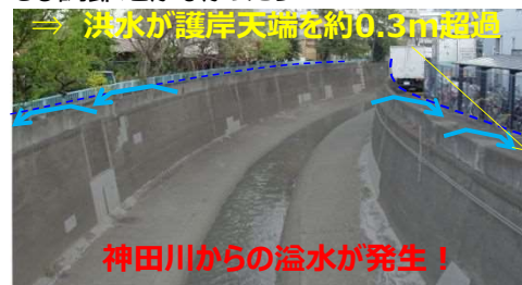
富士見橋：調節池による取水が無かった場合の水位状況
