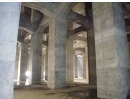
善福寺川調節池
