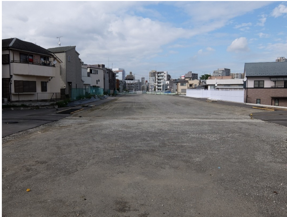
起点部街路築造工事予定箇所
