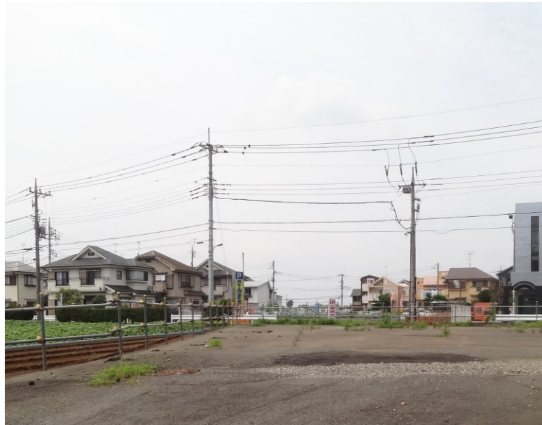
起点部 工事予定箇所
