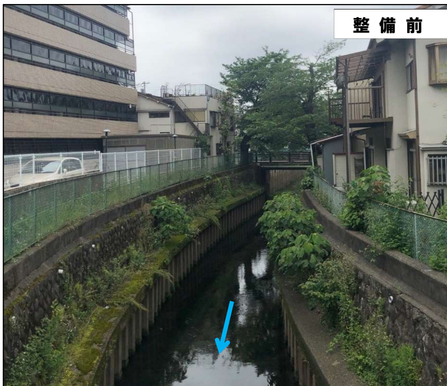
川幅が狭く、流下能力が不足
