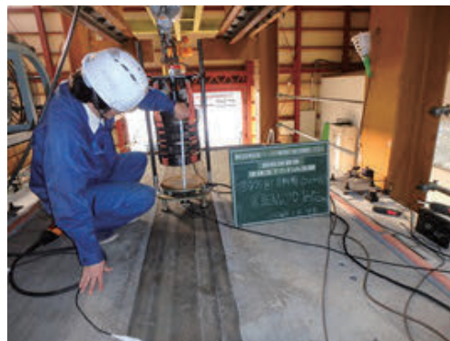
写真-10 重錘落下たわみ試験機
