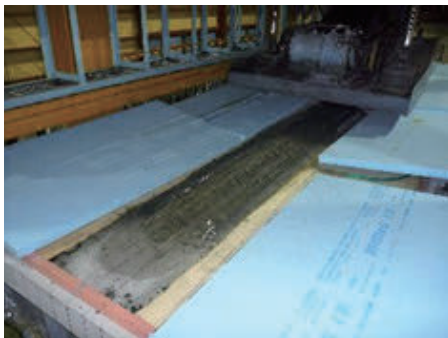
写真-3 水張り試験状況
