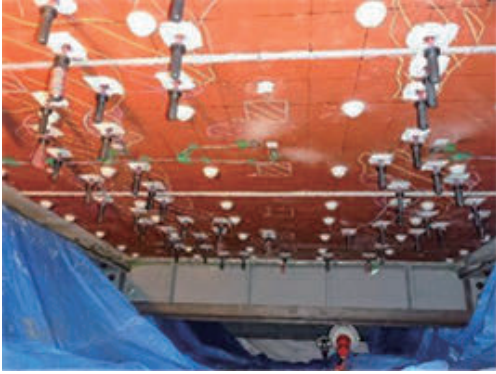
写真-5 接着材再注入状況
