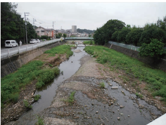
写真-7 空堀川 三郷橋付近
