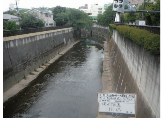
写真-5 石神井川 松橋付近
