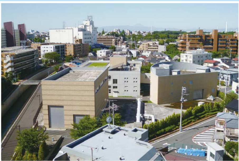
善福寺川取水施設・全景
