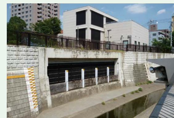
妙正寺川取水施設・取水口
