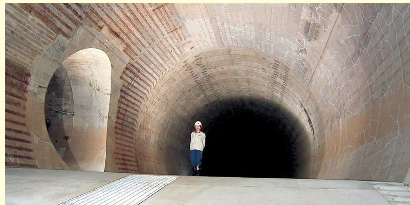
第一期トンネル・善福寺川取水施設連絡管渠接続箇所
