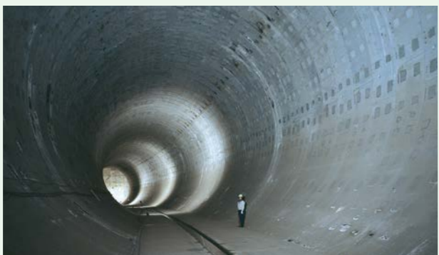
第一期トンネル
