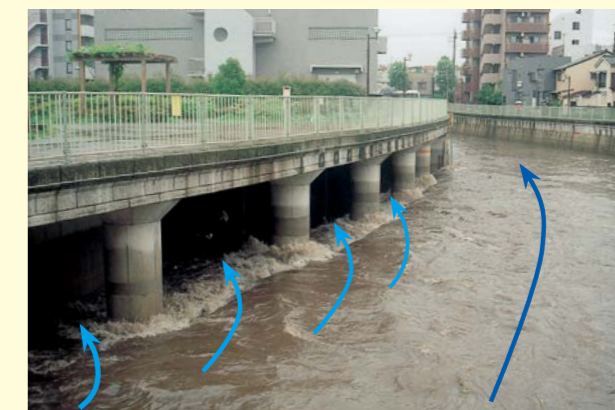
神田川取水施設への流入状況
