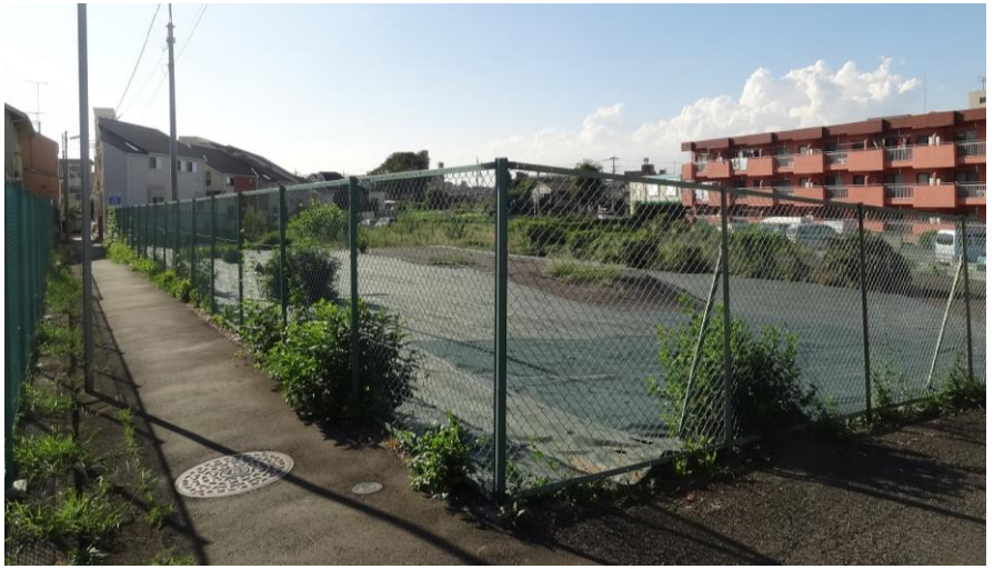
現況(搬入路工事箇所)
