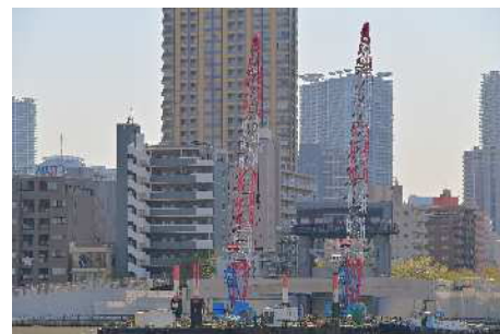
図-4 月島連絡橋架設
