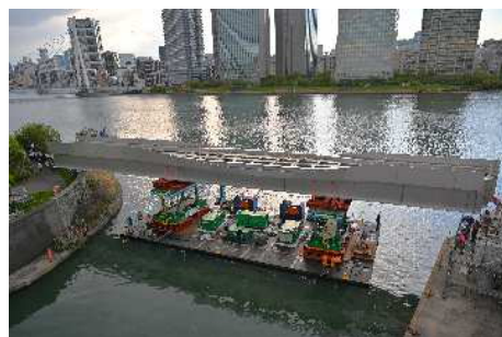
図-5 大島連絡橋架設
