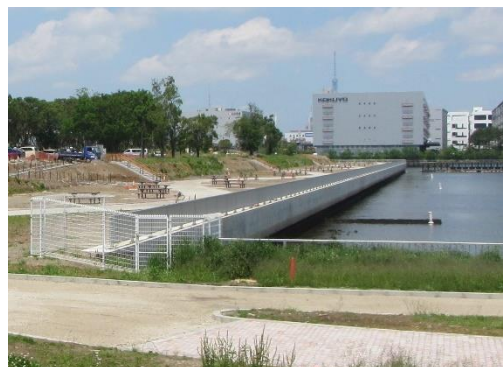
写真-6 護岸改修（夢の島公園）
