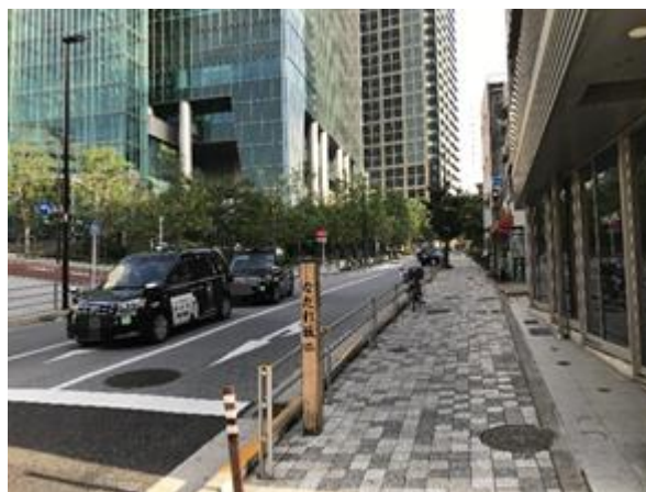
写真：港区道（港区六本木三丁目付近）
