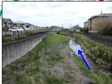
たきやま 滝山橋上流側
