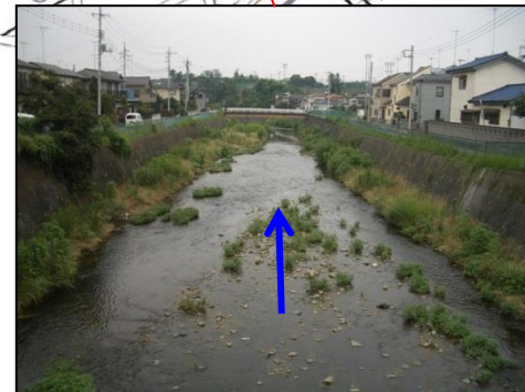
しもだ 下田橋上流側
