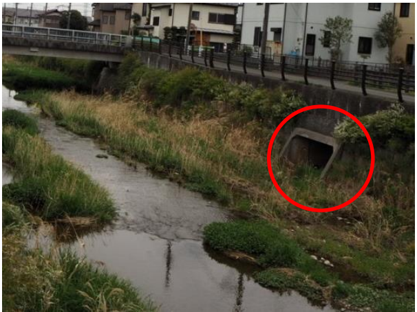
下水（雨水）排水管（整備後）
