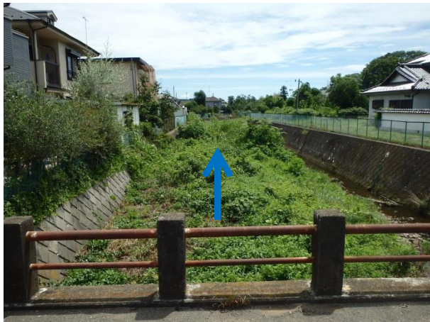
整備前（無量寺橋下流）
