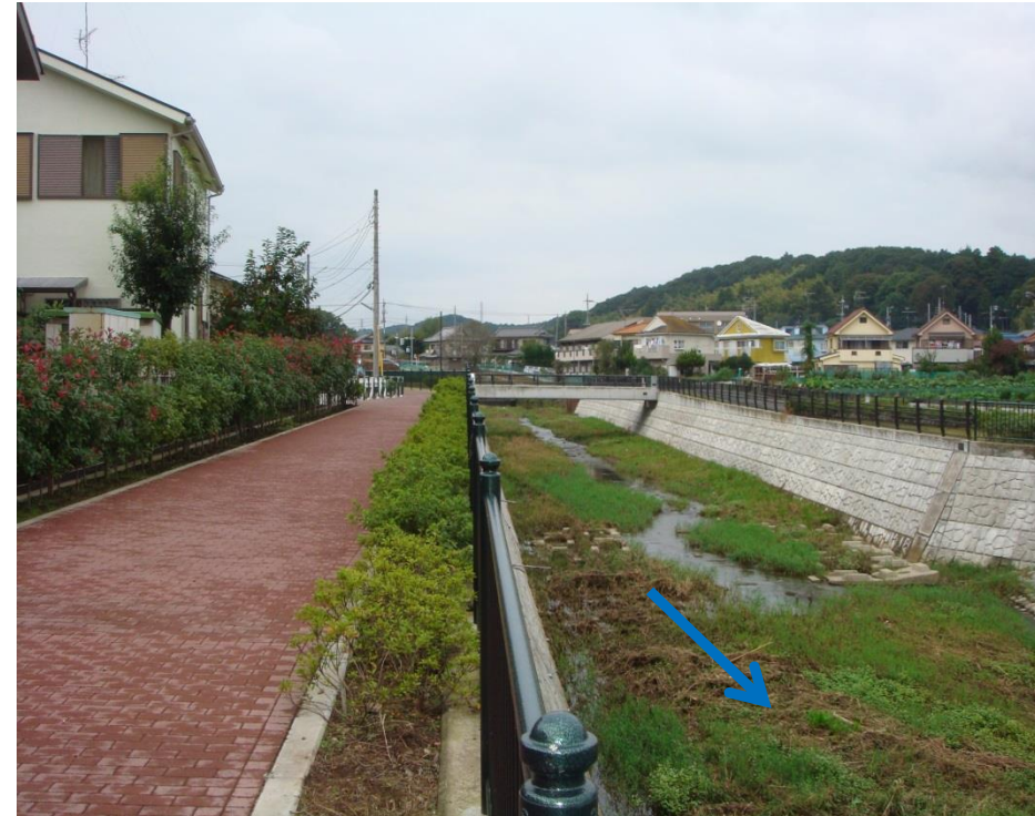
整備後（谷地川 明王下橋下流）
