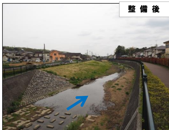
緩傾斜護岸の整備により親水性のある水辺を形成
