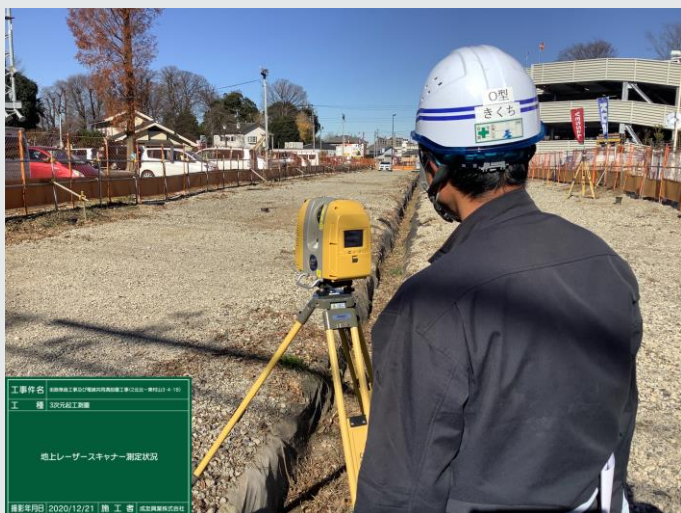
地上レーザースキャナーによる3次元起工測量
