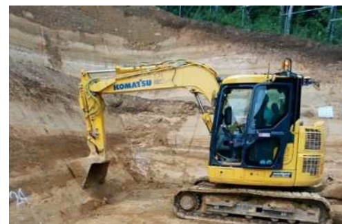
【法面整形の施工状況】
