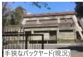
手狭なバックヤード(現況)
