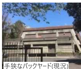
手狭なバックヤード(現況)
