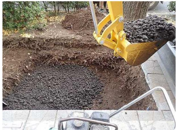
写真IV-1-28 骨材の投入
