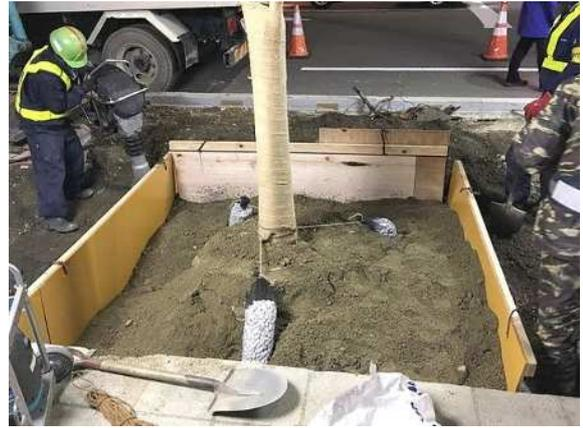
写真IV-1・22、1・23 酸素管の施工状況（植栽木の周囲には S.S.M を使用）
