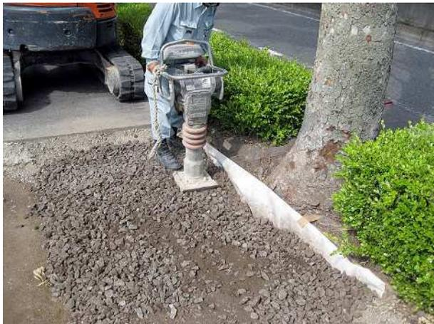
写真IV-1-29 骨材の転圧（防根シート併用）
