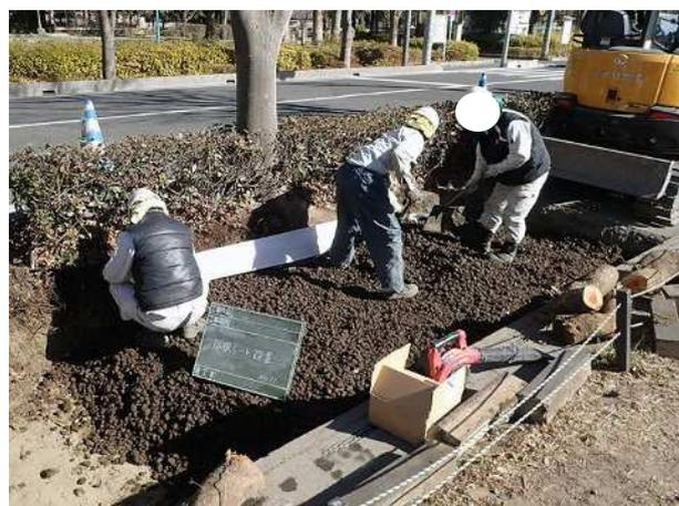
写真IV-1・31 防根シートの施工 (S.S.M 併用)
