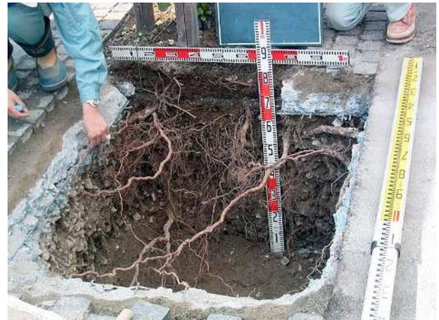
写真IV-1-30 骨材間に伸長する根（ポプラ）
