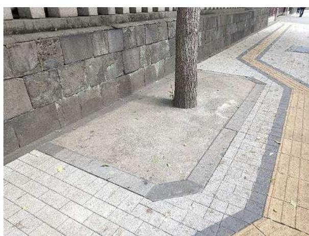
写真IV-1・25 透水性合材の設置
