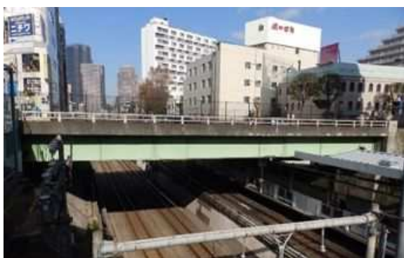
跨線橋の例 上大崎新橋（品川区）
