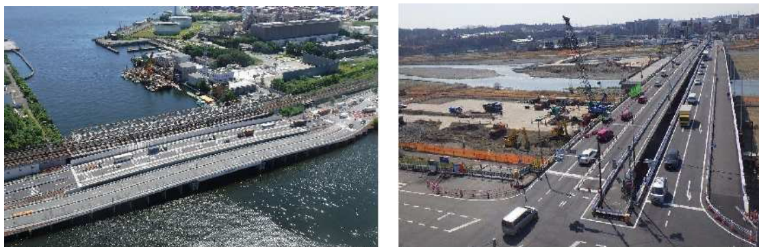
写真2-5 橋梁の更新事例
