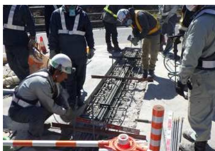
写真5-1 伸縮装置取替、ひび割れ補修の対策事例
