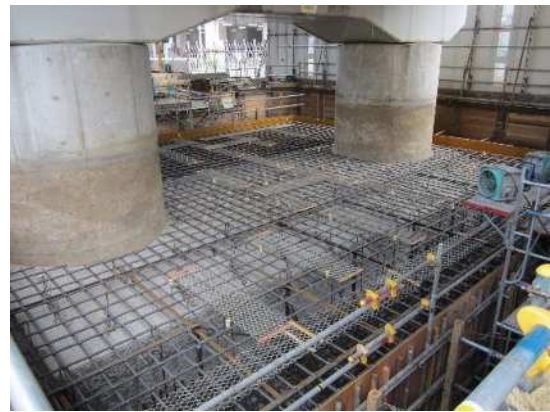
橋脚ワーチングの補強
