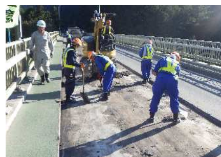
写真5-2 補修工事の事例（左：塗装の塗替、右：橋面舗装の打ち替え）
