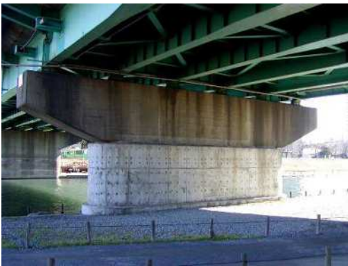
写真2-1 橋脚補強（RC巻き立て）
