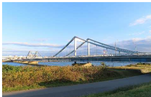
長大橋の例 葛西橋（江東区～江戸川区）
