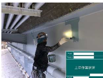
写真5-2 補修工事の事例（左：塗装の塗替、右：橋面舗装の打ち替え）
