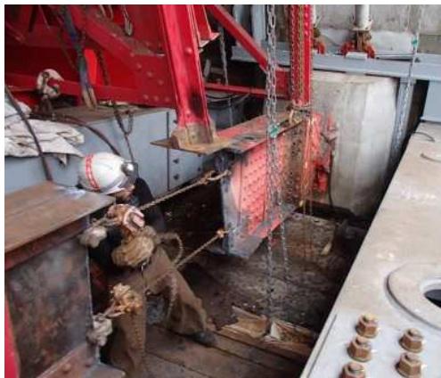
アーチリブの取替え
