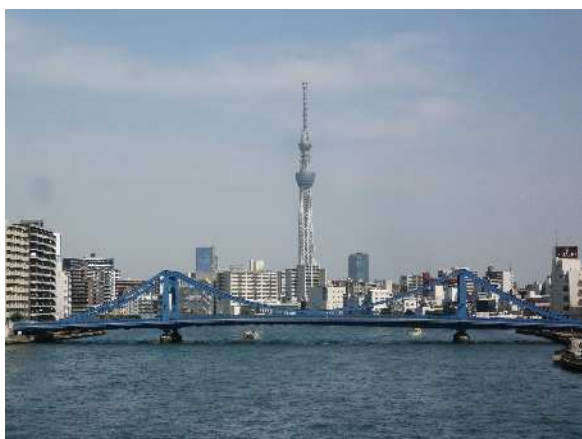
清洲橋（中央区～江東区）
