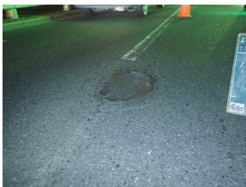
大型車両の繰り返し载荷や雨水によるRC床版上面の土砂化
