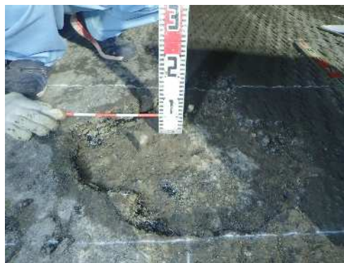
大型車両の繰り返し载荷や雨水によるRC床版上面の土砂化
