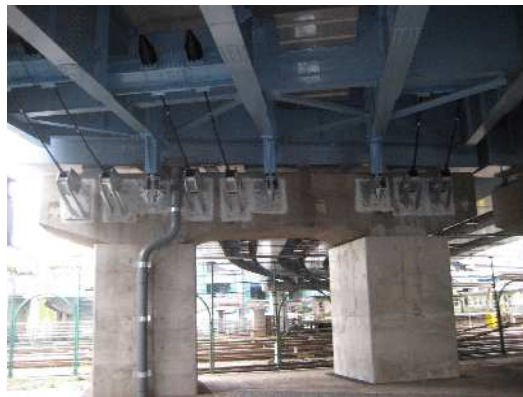
写真2-2 落橋防止システムの強化
