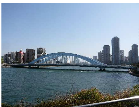
永代橋（中央区～江東区）
