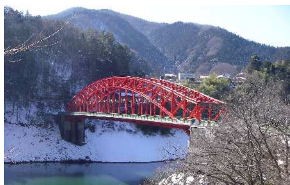
山間部橋梁の例 峰谷橋（奥多摩町）
