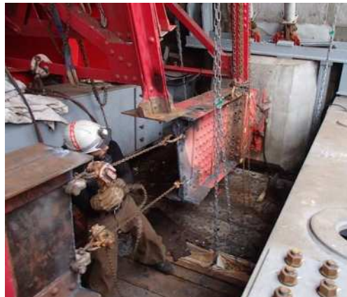
写真 2－4 アーチリブの取替
