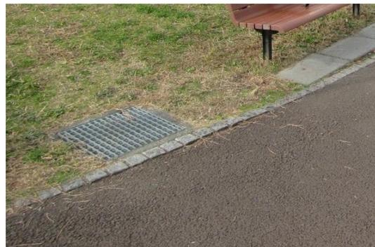
写真4 排水溝（ます） 園路の外側に設置されている。
