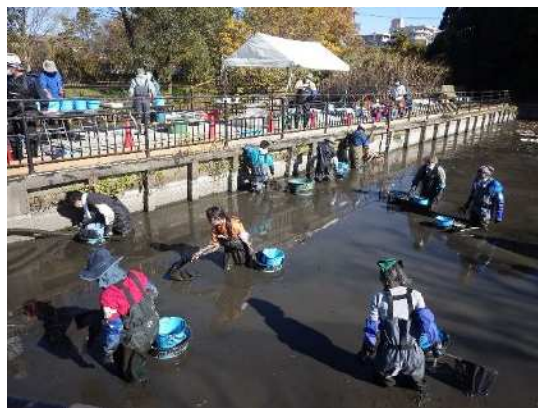
池の中での作業状況
