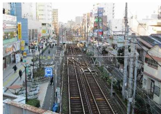
（荒川区町屋一丁目付近）
