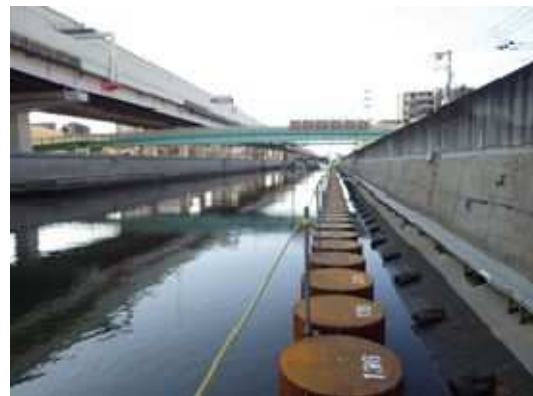
綾瀬川（足立区加平二丁目付近）
